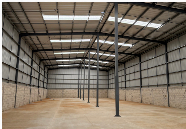
INTERIOR DE NAVE
